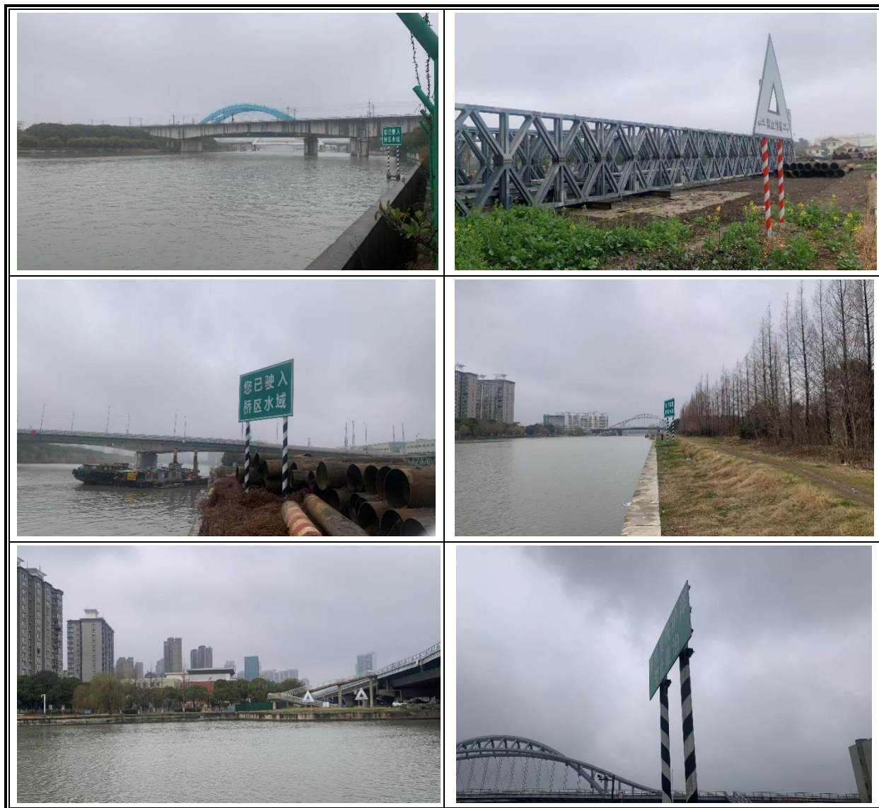
图 2.3-13 沿线标志标牌实景图
