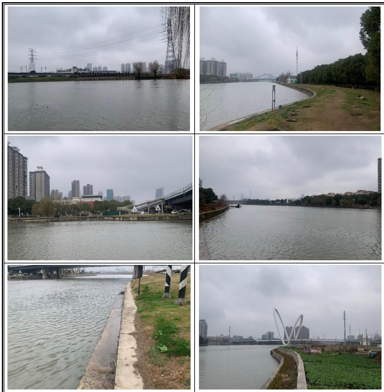
图 2.3-11 航道护岸实景图
