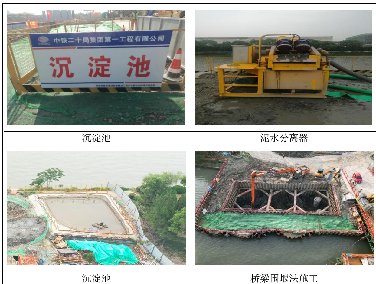
图 6.1-1 施工期水环境保护措施图片
