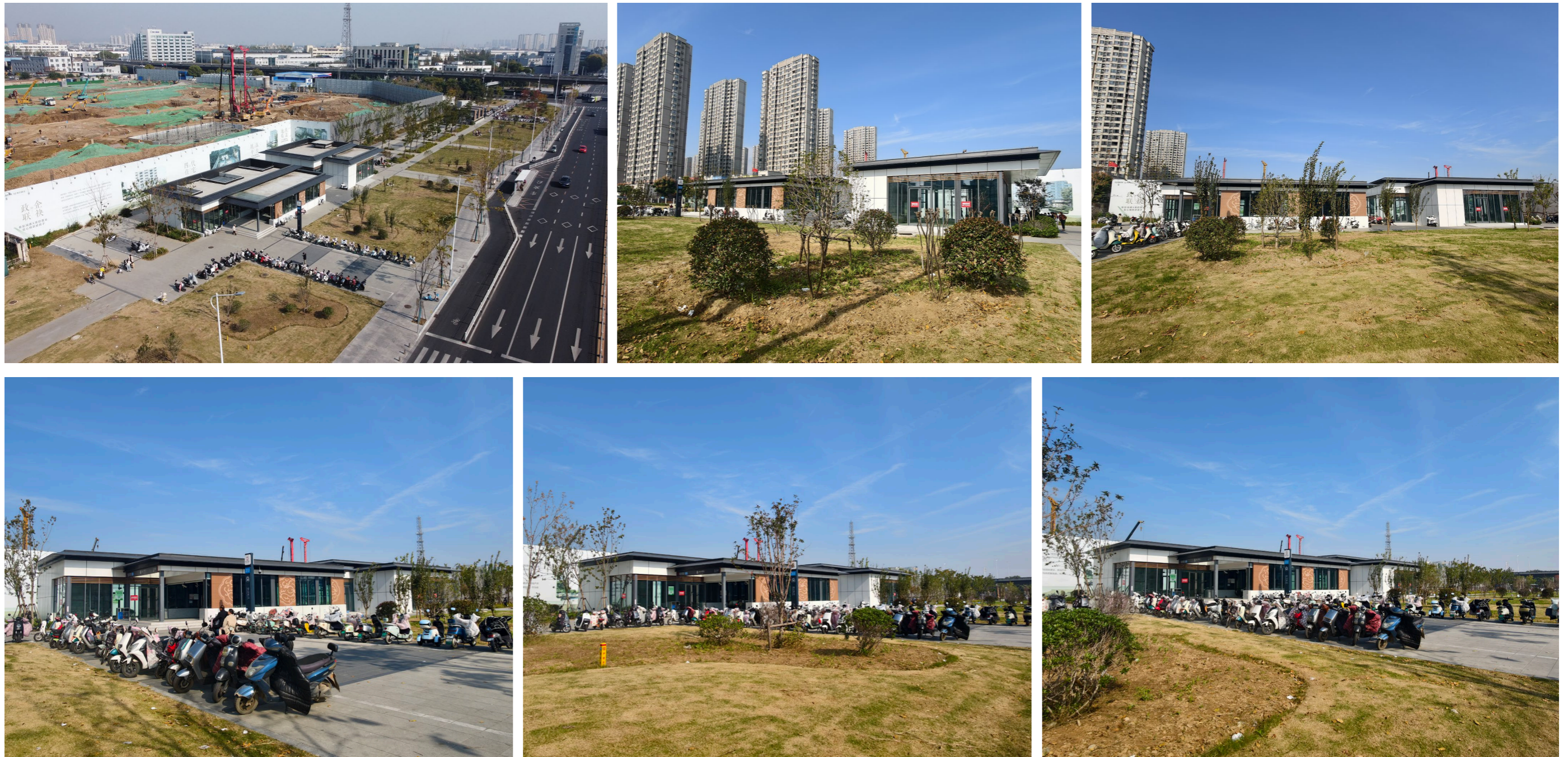
(2) 金山桥副中心站附属整合建筑现场实景照片
