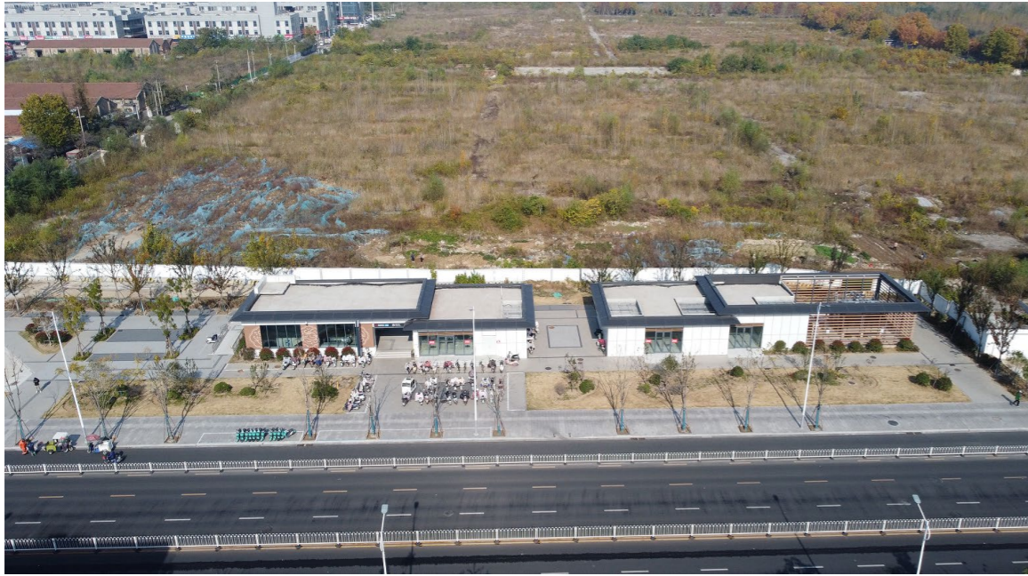
(1) 徐钢医院站附属整合建筑现场实景照片
