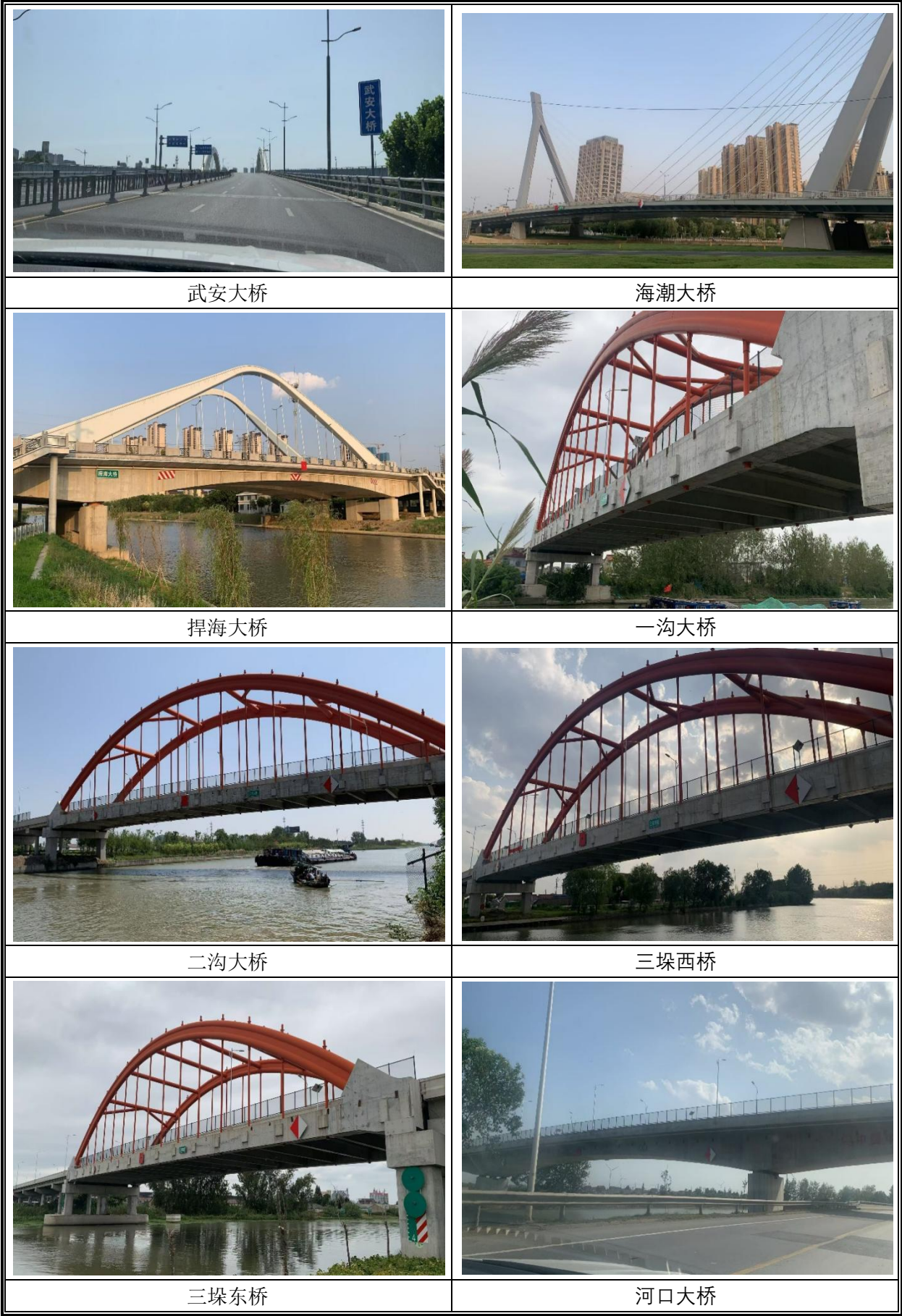
图 2.3-12 沿线桥梁工程实景图
