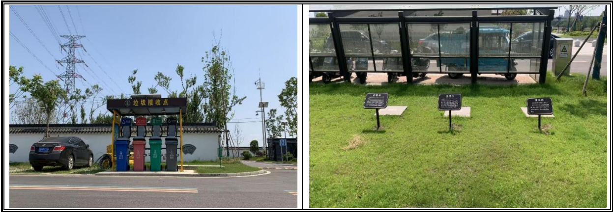
图 6.2-3 船舶生活垃圾接收装置及服务生活污水处理装置
