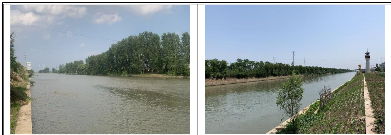
图 2.3-11 航道护岸实景图
