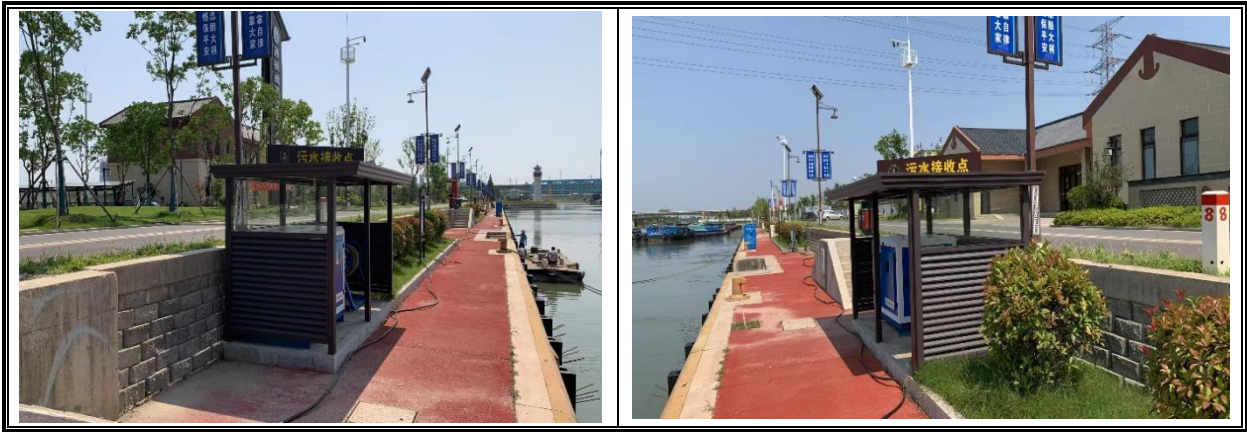
图 6.2-2 船舶生活污水接收装置
