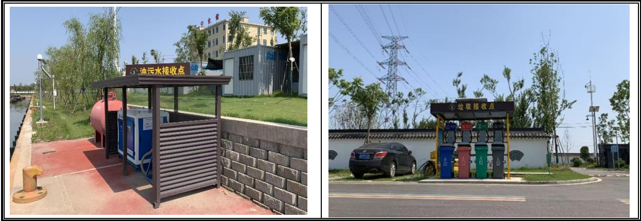
图 6.2-1 船舶油污水及生活垃圾接收装置
