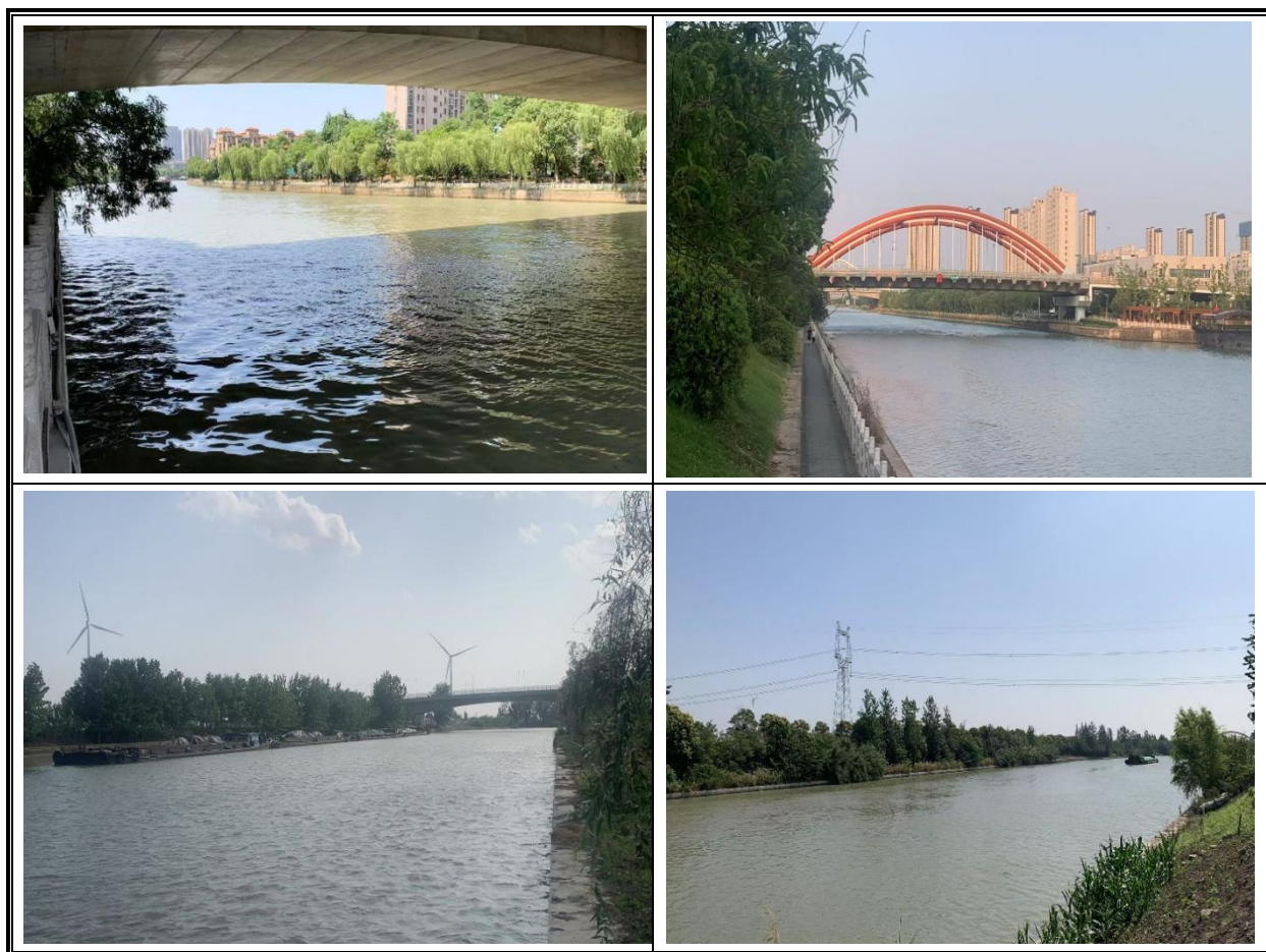
图 5.4-1 本项目沿线绿化工程实景图
