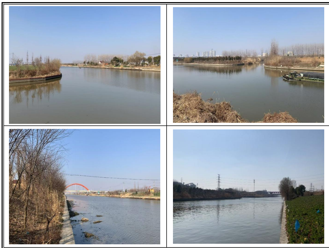
图 2.3-2 航道护岸实景图
