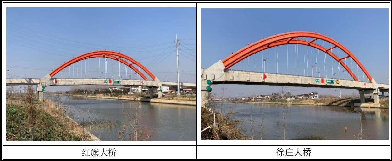
图 2.3-4 沿线桥梁工程实景图
