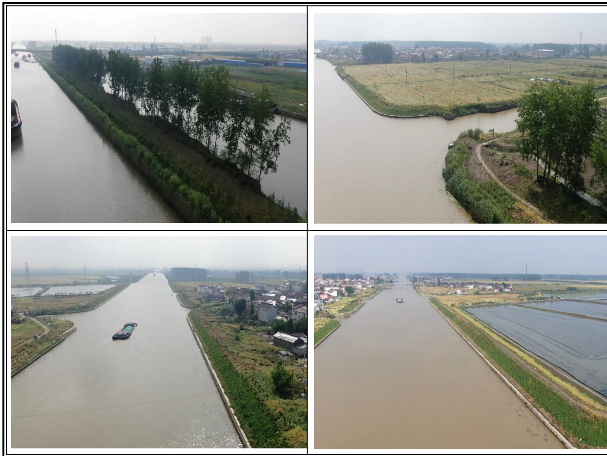
图 5.4-1 本项目沿线绿化工程实景图
