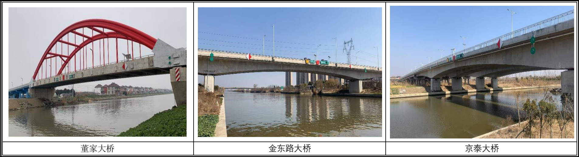
图 2.3-3 沿线桥梁工程实景图
