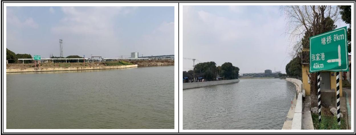
图 2.3-5 沿线标志标牌实景图
