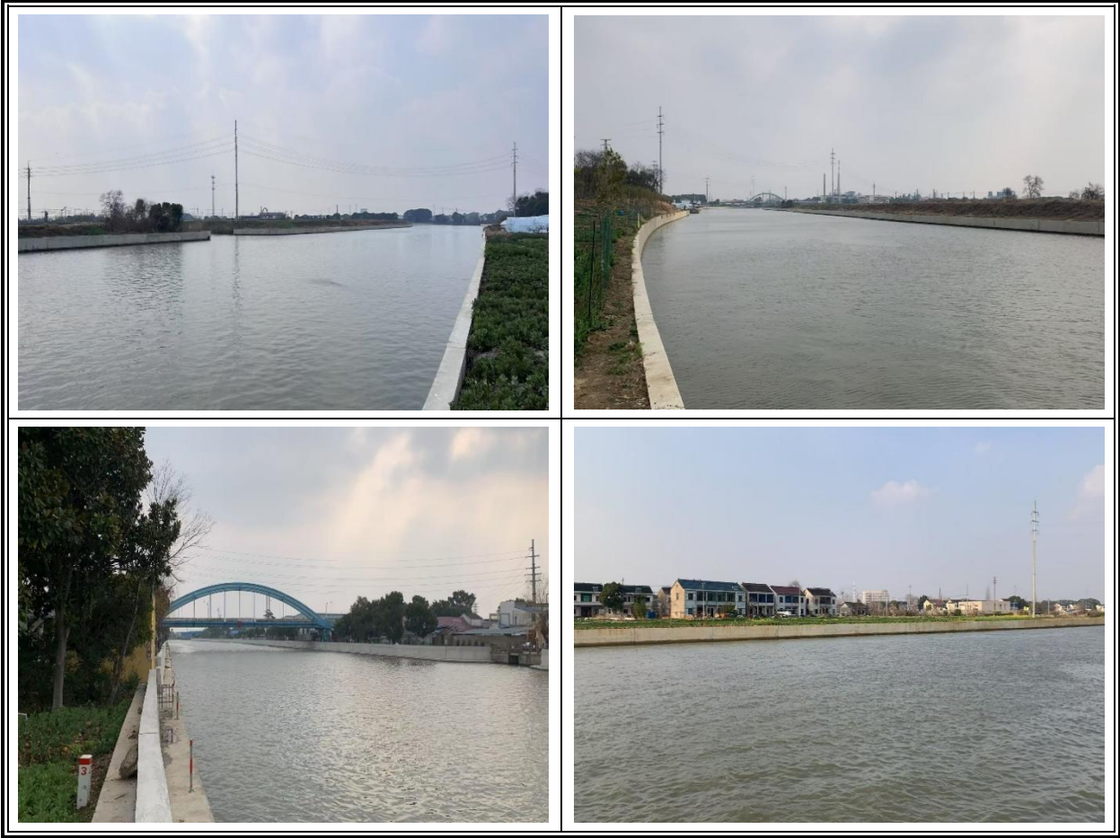
图 2.3-2 航道护岸实景图
