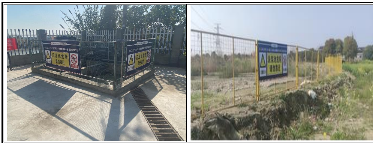
图 6.1-1 施工期水环境保护措施图片
