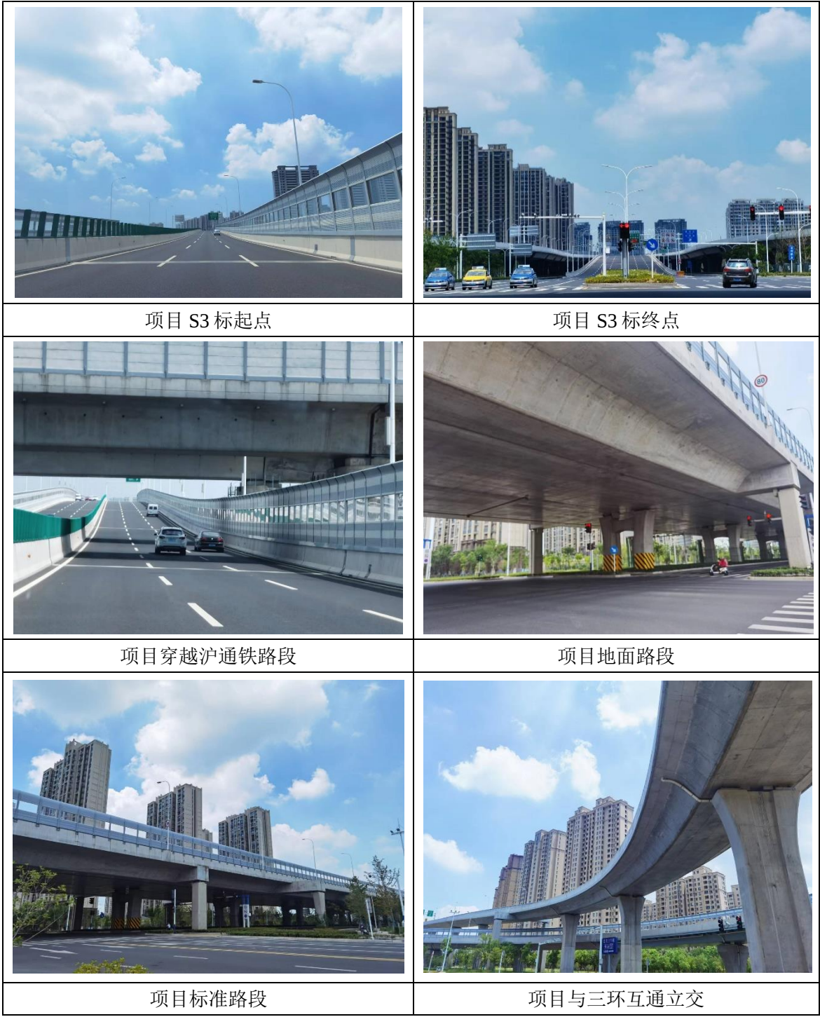
图 2.3-1 建设工程现状图
