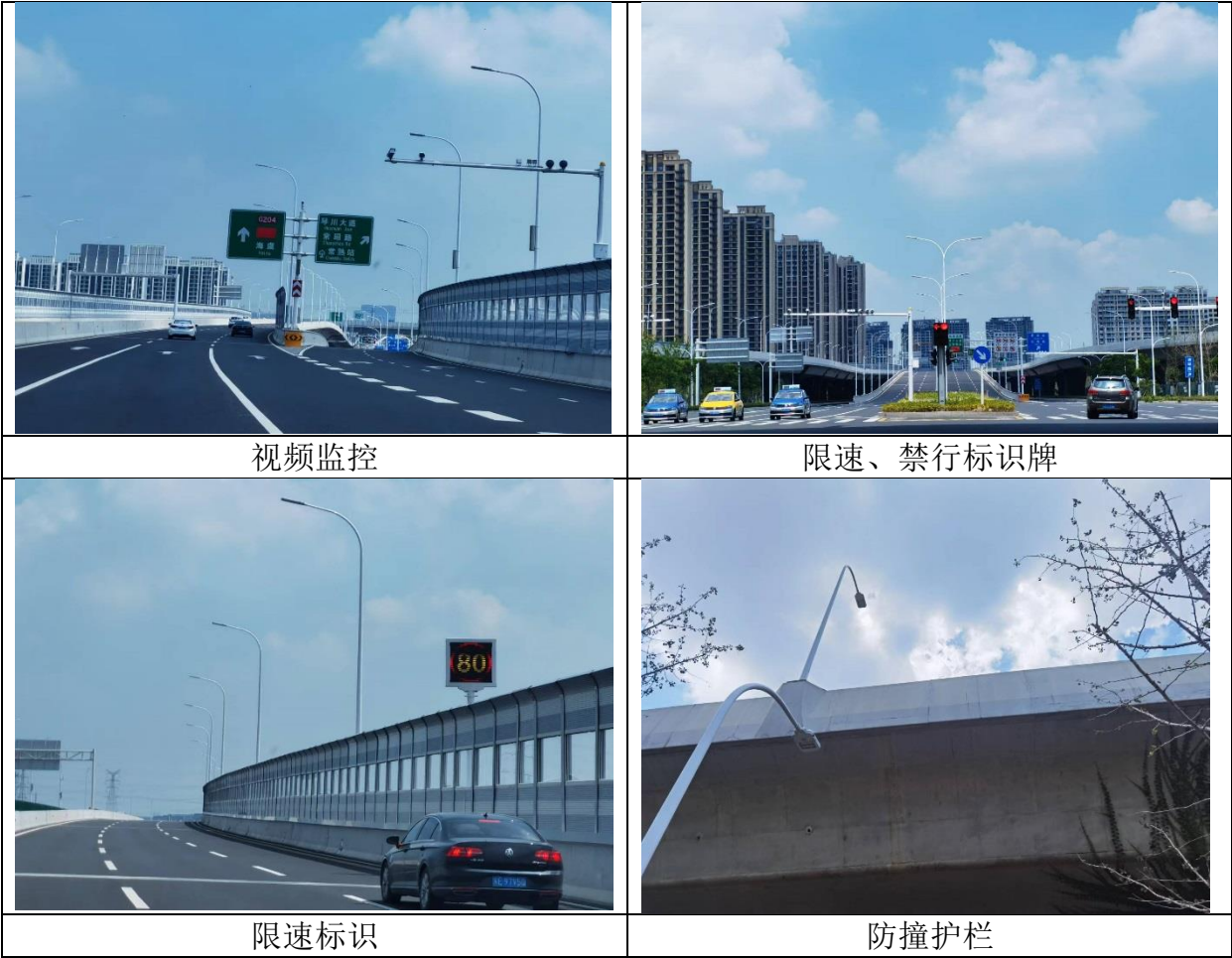
图 10.3-1 环境风险防范措施落实情况
