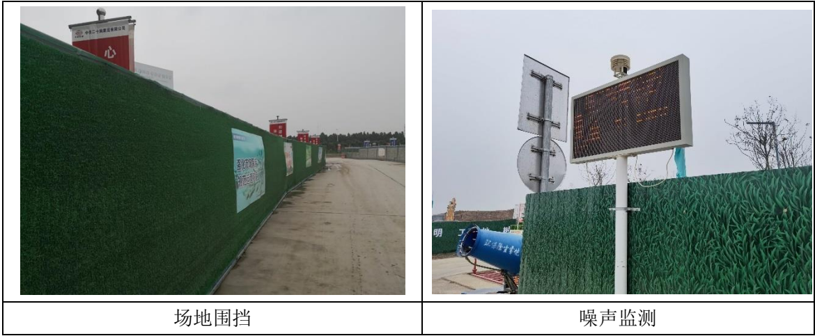
图 6.1-1 施工期声环保措施落实情况
