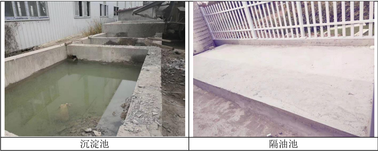
图 7.1-1 施工期污水防治措施落实情况
