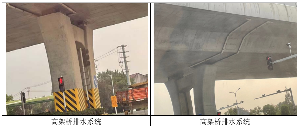
图 7.3-1 本项目采取的高架桥排水系统
