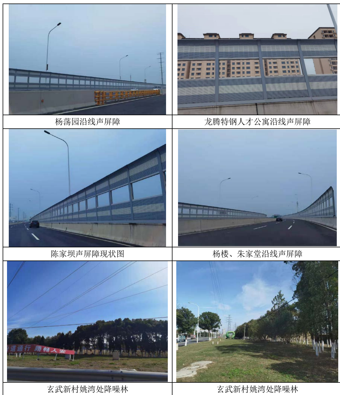
图 6.2-2 声屏障和降噪林建设现状
