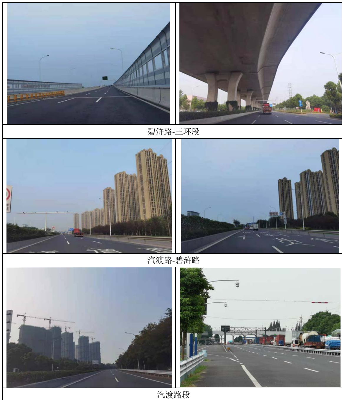
图 2.3-1 建设工程现状图
