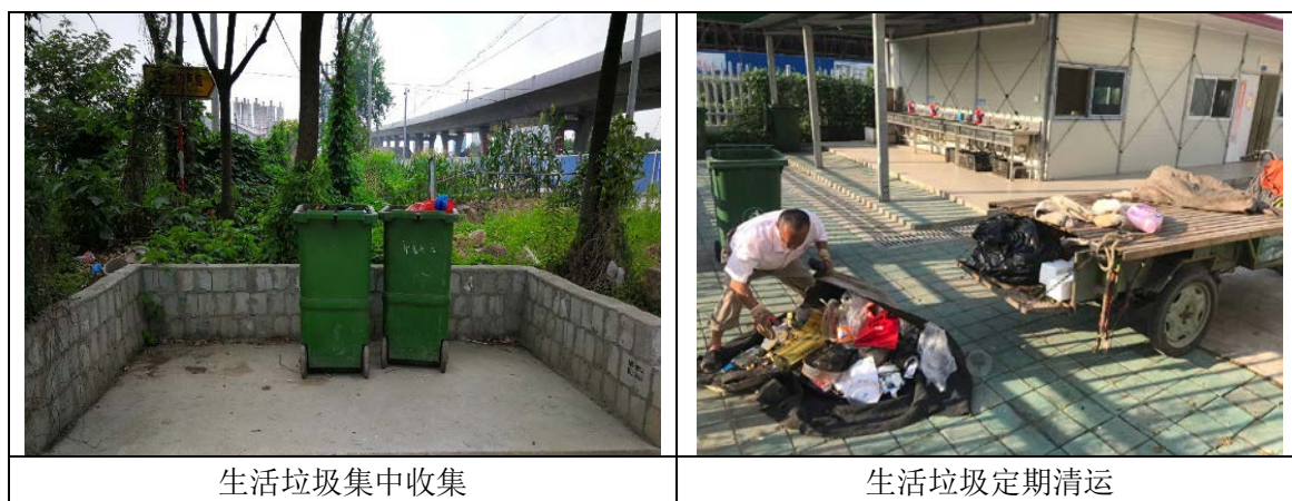
图 9.2-1 施工期固体废物污染防治措施落实情况
