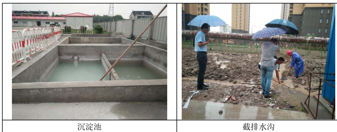
图 7.1-1 施工期污水防治措施落实情况
