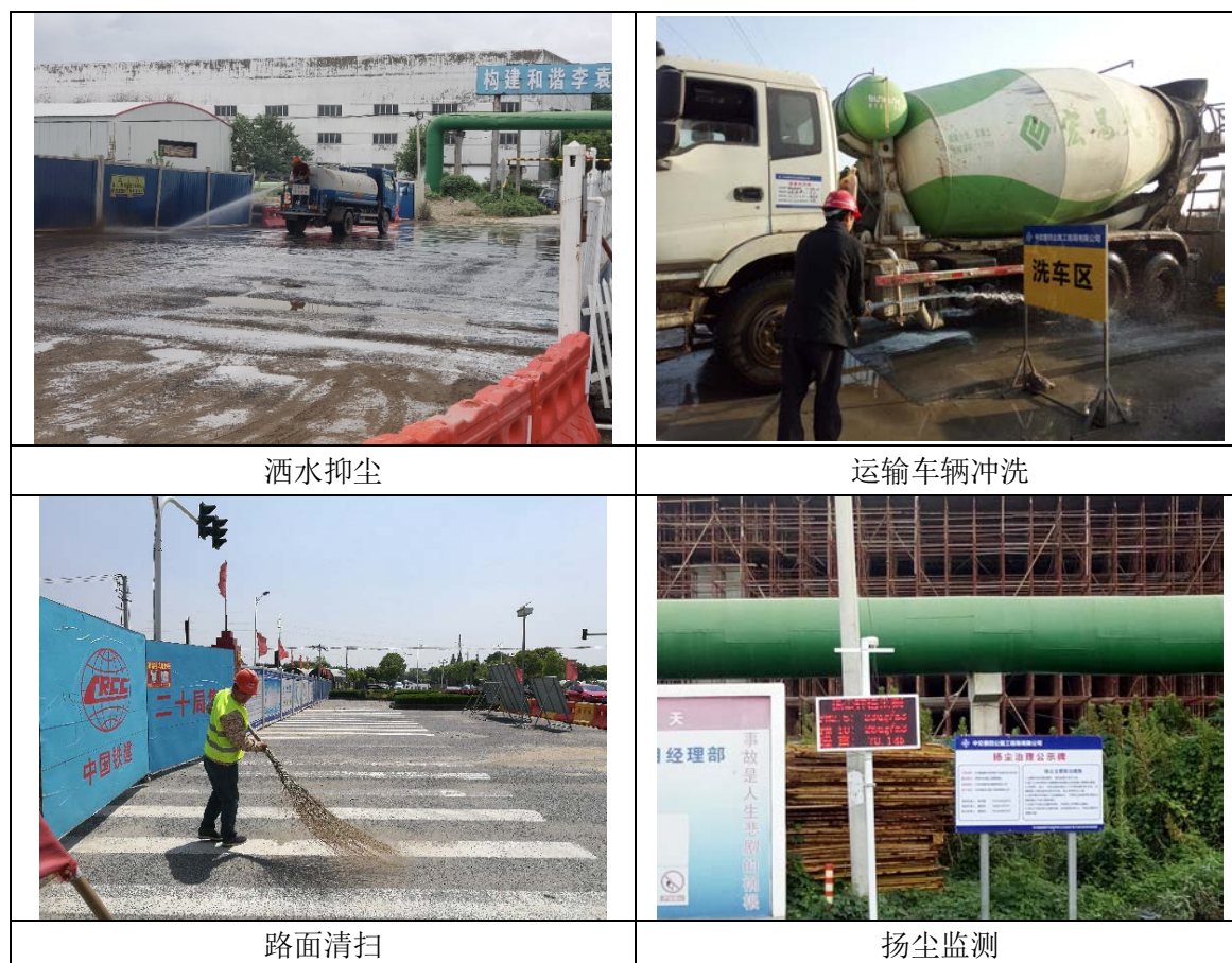
图 9.1-1 施工期扬尘防治措施落实情况
